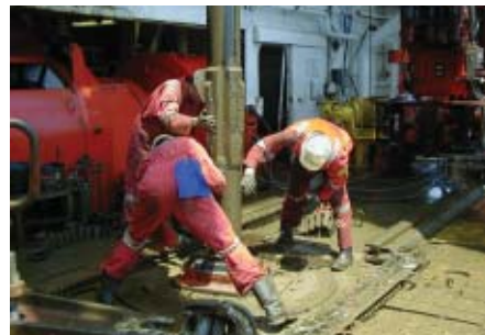
西オーストラリア州沖合掘削現場
