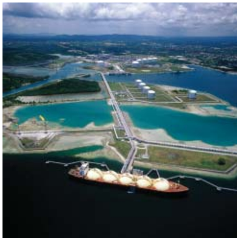
東カリマンタンボンタンLNGプラント
