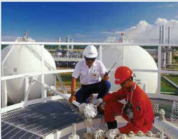
サンタンLPG貯蔵施設
