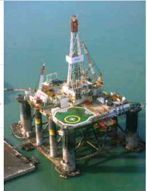
WA-285-P鉱区 掘削リグ
