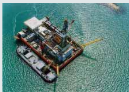
北カスピ海掘削現場
