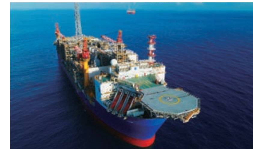
イクシスLNGプロジェクト FPSO(沖合生産・貯油出荷施設)
