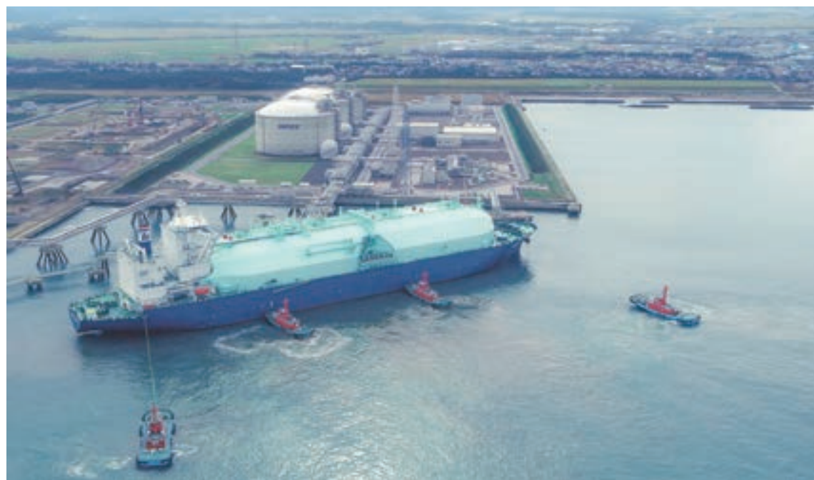
新潟県直江津LNG基地に入港するLNG船(オセアニック・ブリーズ)
