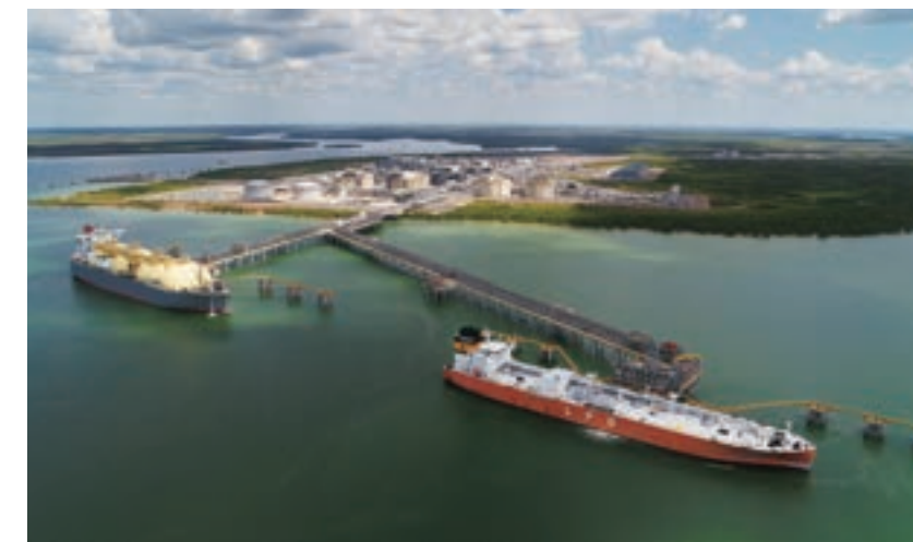
イクシスLNGプロジェクト 陸上ガス液化プラント
