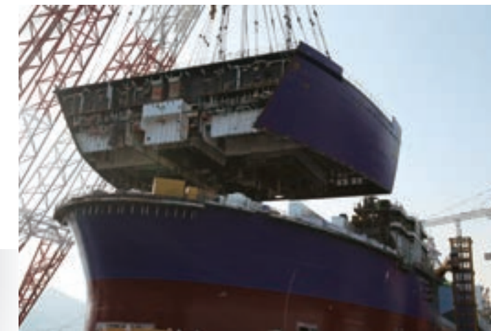
イクシスLNGプロジェクト 沖合生産・貯油出荷施設(FPSO)の建造の様子
