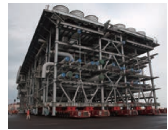
イクスLNGプロジェクト LNGプラント用モジュールの搬入の様子
