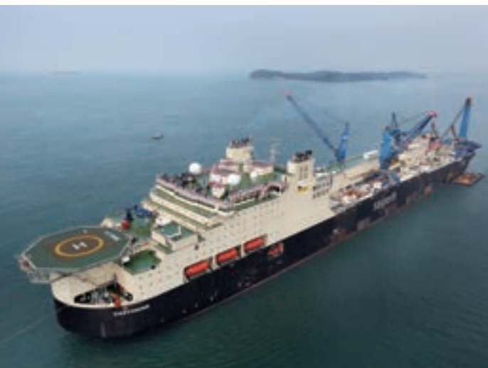
イクスLNGプロジェクト ガス・輸送パイプラインの敷設の様子
