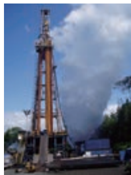
地熱発電用調査井の掘削風景
