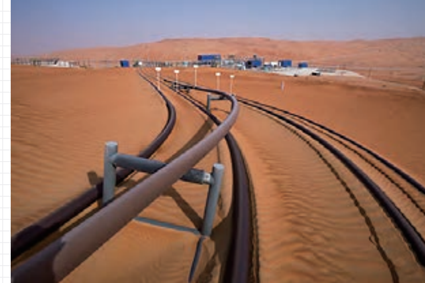
陸上パイプライン
