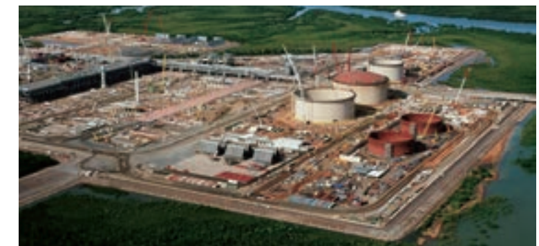
イクスLNGプロジェクト 陸上施設建設の様子
