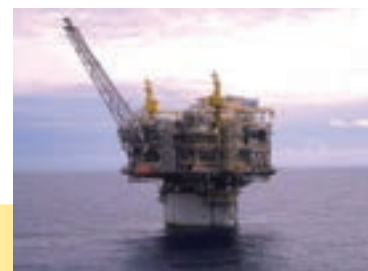
ルシウス油田海上生産施設
