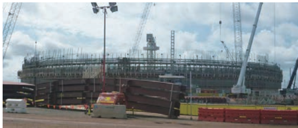
イクシスLNGプロジェクト陸上ガス液化プラントサイトにおけるLNGタンクの建設状況(2014年4月、ダーウィン)
