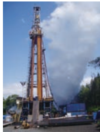
地熱発電用調査井の掘削風景
