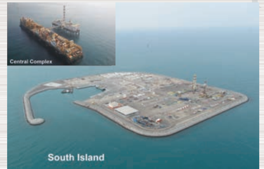
ADMA鉦区 上部ザクム油田生産施設(人工島)
