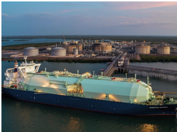
Darwin LNG Plant and LNG vessels
