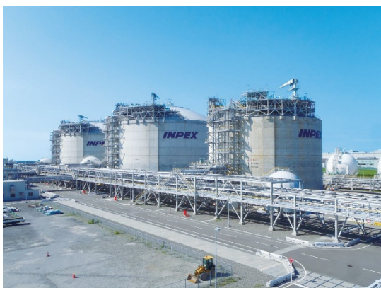
Naoetsu LNG Terminal
