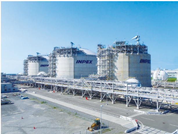
Naoetsu LNG Terminal
