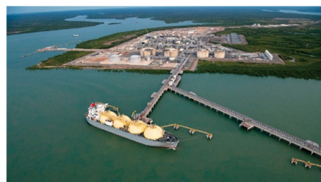
Darwin LNG Plant and LNG vessels
