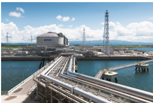
Naoetsu LNG Terminal
