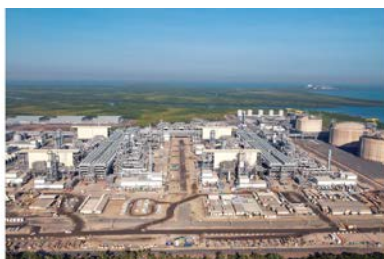
Darwin LNG Plant
