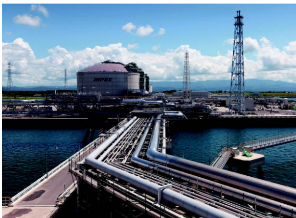
Naoetsu LNG Terminal (receiving terminal)
