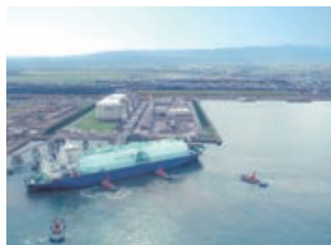
LNG tanker entering the Naoetsu LNG Terminal
