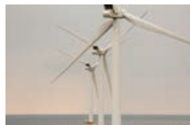
Luchterduinen Offshore Wind Farm
