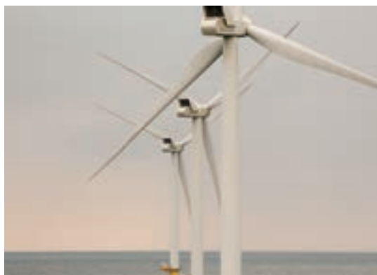
Luchterduinen Offshore Wind Farm
