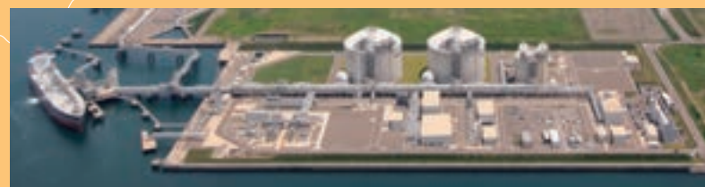
Naoetsu LNG Terminal
