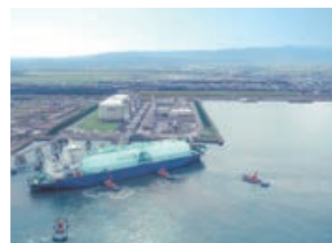
LNG tanker entering the Naoetsu LNG Terminal
