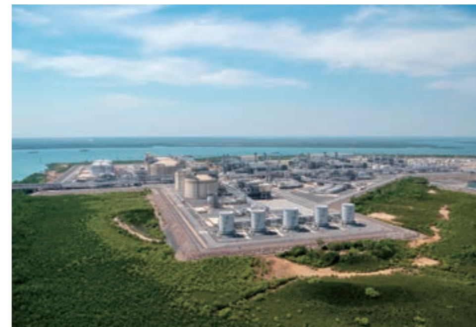
Ichthys LNG Project Onshore LNG Plant
