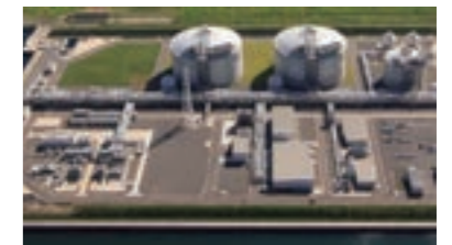
Naoetsu LNG Terminal
