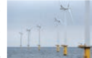
Luchterduinen offshore wind farm
