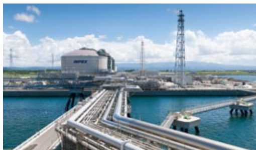
Naoetsu LNG Terminal
