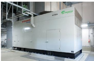
停電発生時の対応として非常用ディーゼル発電機・ガスタービン発電機を備えています。停電時、保安用電力としてディーゼル発電機で設備の安全を図り、停電が長期に及ぶ場合は、ガスタービン発電機を稼働させて操業を継続することが可能です。
