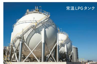
熱量調整のため使用されるLPGを貯蔵するタンクです。常温LPGタンクと低温LPGタンクの2種類あります。
