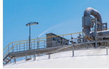
散水設備は、隣接火災の放射熱の影響を抑える目的でLNGタンク、低温LPGタンク、常温LPGタンクに備えられています。万が一の火災発生時には、放射熱によって加熱されることがないように、散水してタンクを冷やし、被害の拡大を抑えます。このほか隣接設備への延焼防止、施設の変形、倒壊防止も図ります。
