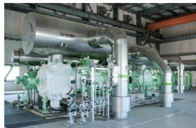
LNG・低温LPGタンクでは、微小な入熱によりボイルオフガス (BOG) が常に発生します。LNGタンクのBOG処理方法は2パターンあり、一つは再液化しタンクもしくは気化設備に送り込む方法、もう一つは高圧圧縮して気化ガスラインに直接送り込む方法です。低温LPGタンクのBOG処理方法は再液化して常温LPGタンク又は低温LPGタンクに送り込みます。これらの処理によりBOGを大気放散することなく、環境に優しい操業が可能になります。
