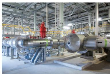
気体に戻った天然ガスは、熱量調整設備にてLPG (液化石油ガス) を加え熱量調整を行い、製品ガスとしてパイプラインネットワークへ送られます。
