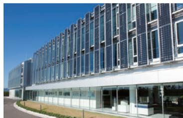
当基地では事務管理棟、パイプライン監視センター棟の南東壁面と屋上に、積雪地域に強い高効率多結晶モジュールの太陽光パネルを設置し発電しています。これにより棟内電力の一部を賅っています。
