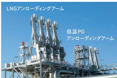
LNG 船・低温LPG 船からLNG、低温LPGを荷揚げしてタンクへと送り込む荷役設備です。LNGのアンローディングアームには油圧駆動のクイックカバーが付いており船側フランジとの接続・切り離し作業を安全かつ確実に行うことが可能です。
