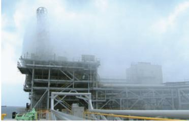
荷役中に火災が生じた際、船・基地設備へ影響を拡大させないことを目的として棧橋に水幕設備を備えています。火災時には、高さ20メートル以上の水幕を形成し、火災放射熱が隣接設備に及ぶのを防ぎ、被害の拡大を抑えます。また、気化ガスを上方へ拡散し、地上付近のガス濃度を早期に低減させます。
