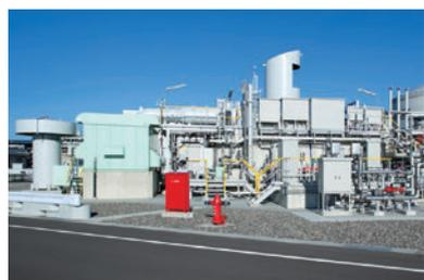
主に緊急時に使用される気化器です。天然ガスをバーナーで燃やし、高温の燃焼ガスを熱源として水槽を温め、水槽内に沈められた伝熱管でLNGを気化させます。
